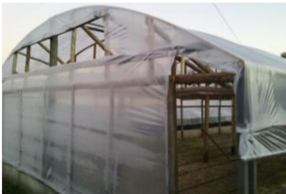
**Figura 1.** Estufa tipo capela de madeira. Fonte: os autores (2020).
