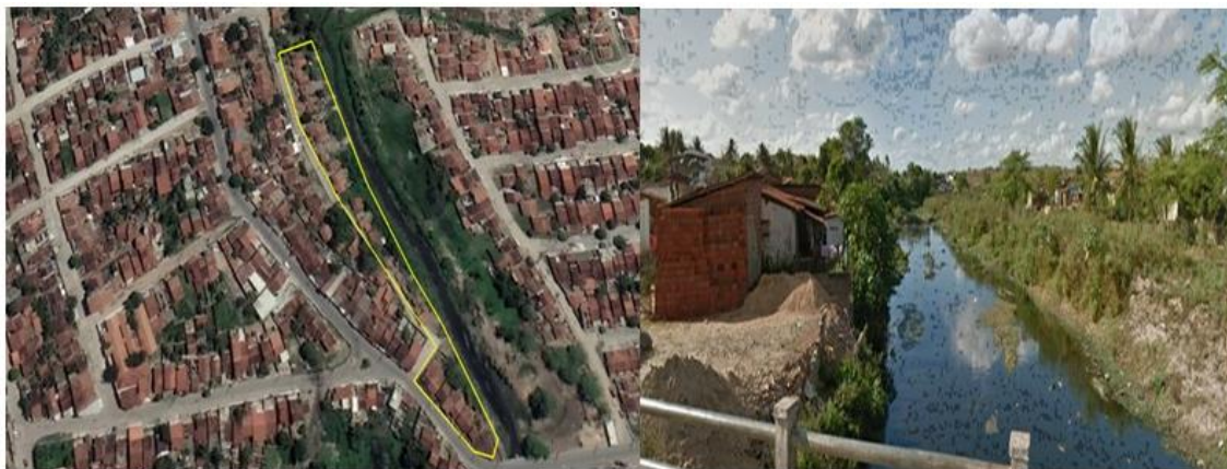
Figura 5. Edificações construídas às margens do Riacho de Bodocongó, no bairro do Cruzeiro.
