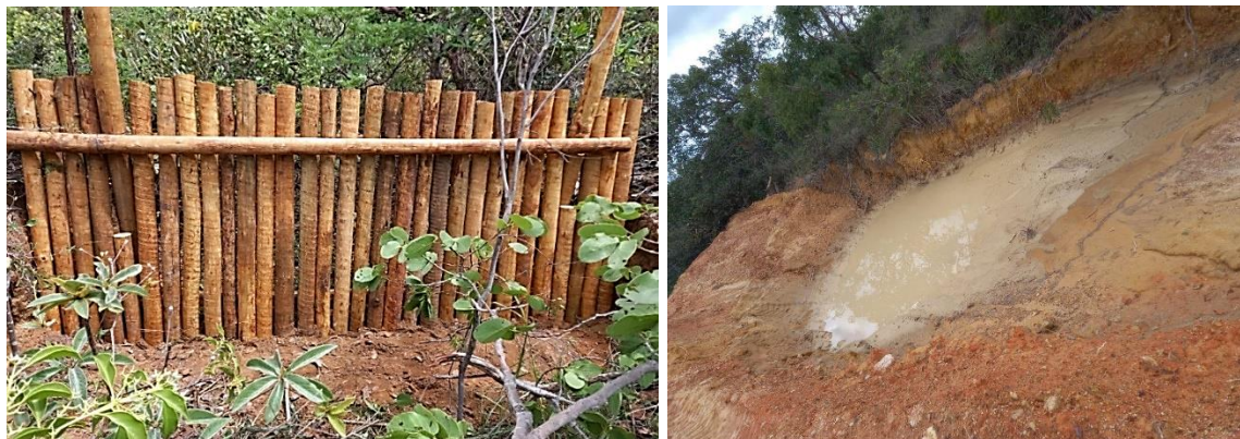
Figura 3. Paliçada e caixa de contenção (barraginha) construídas dentro do PECGerais durante a execução do Projeto SENDAS. Fonte: Os Autores.
