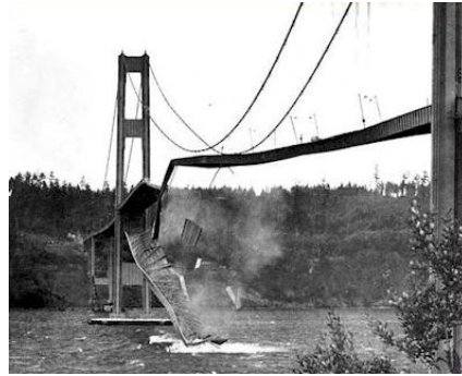
Figura 9. Colapso da ponte Tacoma Narrows. Fonte: http://www.lib.washington.edu/
