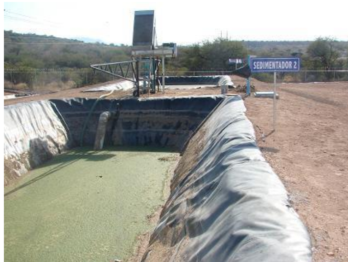
Figura 15. Sedimentador 2 y separador de fibras finas para residuos del sistema de biodigestión mesofílica de biomasa de nopal.
