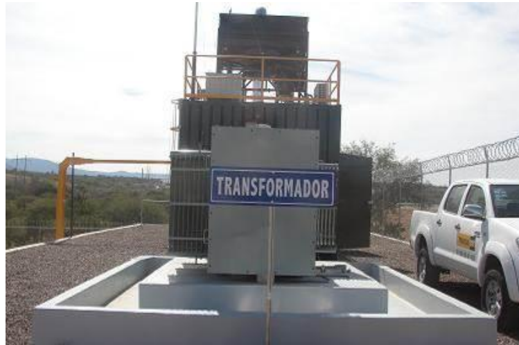
Figura 11. Vista del generador para elevar de 480 a 13200 volts.
