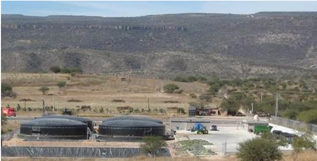
Figura 1. Vista aérea de la planta piloto para la generación de biogás y energía eléctrica a partir de biomasa de nopal en Calvillo, Aguascalientes.
