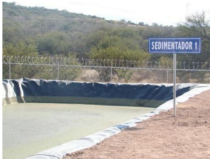
Figura 14. Sedimentador 1 para residuos del sistema de biodigestión mesofílica de biomasa de nopal.
